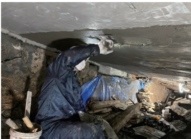
5 コテ仕上げ状況
