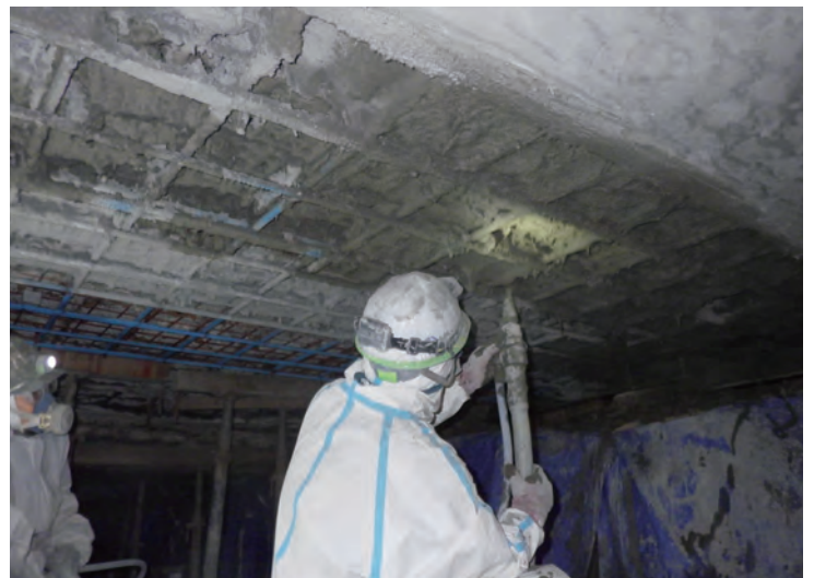
4 ポリマーセメントモルタル吹付状況
