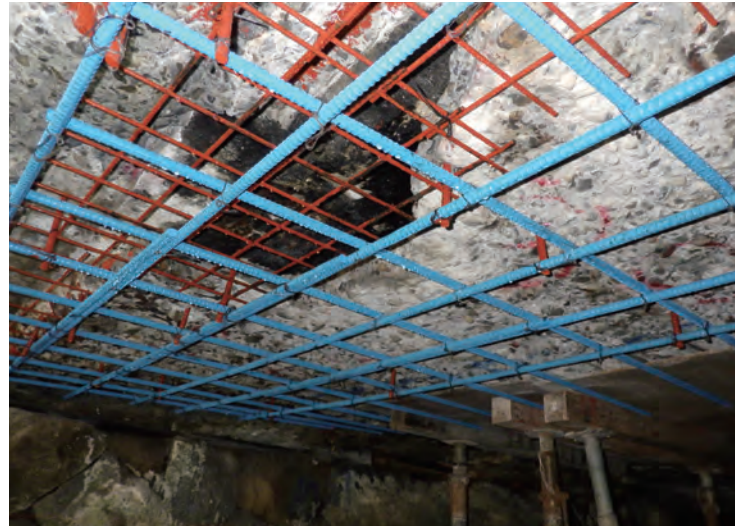
2 鉄筋組立状況（エポキシ被覆鉄筋）
