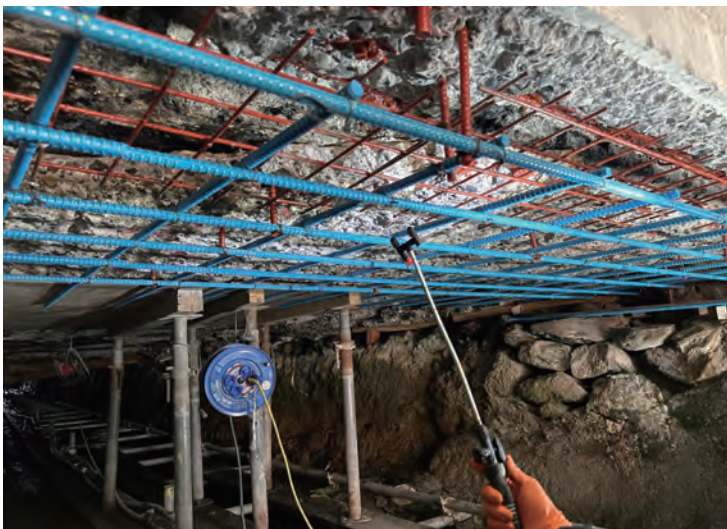
3 含浸材塗布（亜硝酸リチウム）
